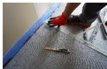
Debe comprobarse que la lámina de PE de la lira lateral queda por encima del elemento base una vez terminada la instalación.
