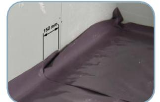
La colocación de esta lámina de polietileno, se efectúa desenrollando, cortando y desplegando dicha lámina. Teniendo en cuenta, que debe solapar en los cerramientos verticales y con sucesivas láminas (aprox. 15 cm.).
