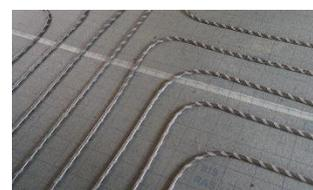
3. El tubo siempre se coloca en forma de espiral dejando libre el camino de vuelta con el fin de colocar el retorno del circuito. Así una vez se llega al centro, se vuelve con el tubo entre las filas de tubo ya colocados, para completar el circuito.
