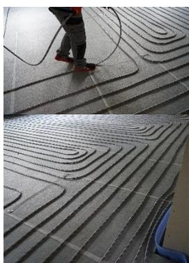
2. Los radios de curvatura deben ser amplios para evitar que la tensión provoque que el tubo se salga de los tochos.(tabla 2)
