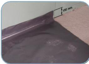
Es necesario la colocación de la hoja PE (barrera antivapor) en las zonas de forjado que estén en contacto directo con terreno natural o en forjados cuya parte inferior esté sometida a temperatura ambiente exterior, para evitar la condensación que se puede formar debajo del aislamiento del suelo radiante.
