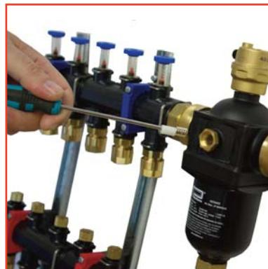
2.- Introducir por la vaina un destornillador de 3 mm de Ø máximo, hasta que los imanes se adhieran y retirar al exterior.
