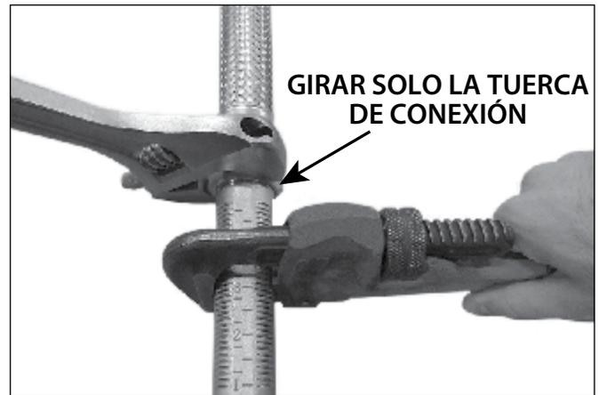
1. Antes de la instalación, compruebe que el sellado dentro de la tuerca de la manguera flexible esté en su sitio y que no esté dañado. Conecte la tuerca a la boquilla reductora del rociador. **LOS REDUCTORES ACODADOS CORTOS DE 90° SUELEN USARSE CON ROCIADORES ENCASTRADOS (FM Y Vds SOLAMENTE).**
