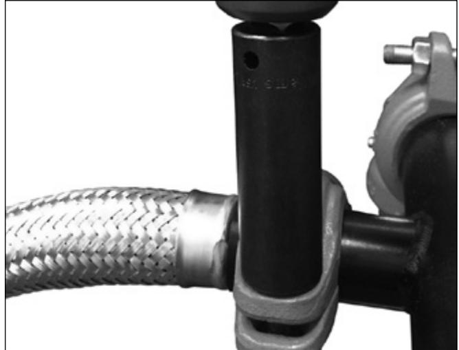
**5. APRIETE LA TUERCA:** Con una atornilladora o una llave de vaso estándar con vaso de 11/16 pulg/17 mm, apriete la tuerca hasta haya contacto metal con metal en el cierre de pernos. Compruebe que las llaves de la carcasa entren completamente en la ranura del tubo del rociador.
