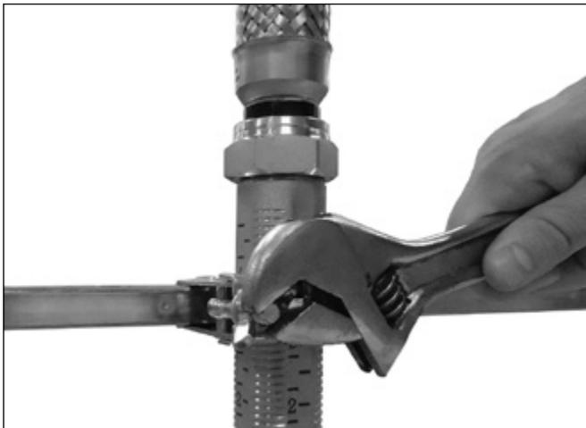
4. Cierre la compuerta central alrededor de la boquilla reductora del rociador. Mueva el tornillo de pivote y la arandela hasta la ranura de la compuerta y apriete la tuerca de mariposa a un par de 50 pulg.-lbs/6 N•m (aproximadamente apretado a mano, más ½ a ¾ de vuelta). **NOTA:** Compruebe que la arandela esté bien asentada debajo de la tuerca de mariposa.
