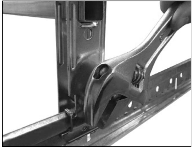
2. Apriete el tornillo de mariposa a cada lado del soporte final a un par de 36 pulg.-lbs/4 N•m (entre ½ y ¾ de vuelta más que el apriete a mano) para fijar los soportes a la barra cuadrada.
