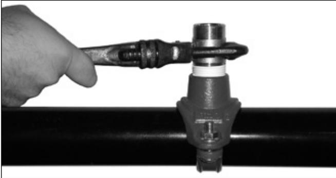
1. Aplique pasta para juntas o sellador de rosca PTFE a las roscas cónicas de la boquilla adaptadora, siguiendo las instrucciones del fabricante de la pasta o de la cinta. Apriete bien la boquilla adaptadora en el tubo del rociador con una llave grifa.
