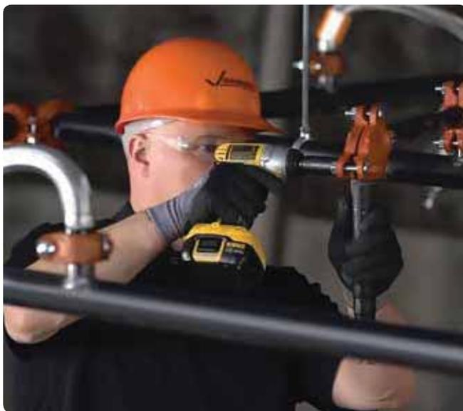
Los productos del Innovative Groove System (IGS) llevan una nueva especificación de ranura IGS patentada para tubos de 1 pulgada y están en la lista cULus y aprobados por FM para presiones de hasta 365 psi | 2517 kPa | 25 bar.
